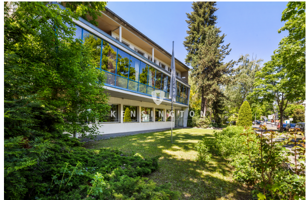
Grundstück mit Abrissgebäude
