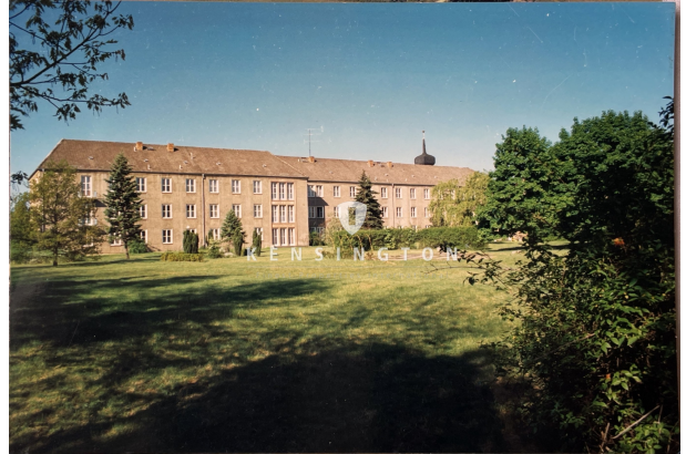
*Ansicht von Parkfläche aus - Aufnahme aus 2006
